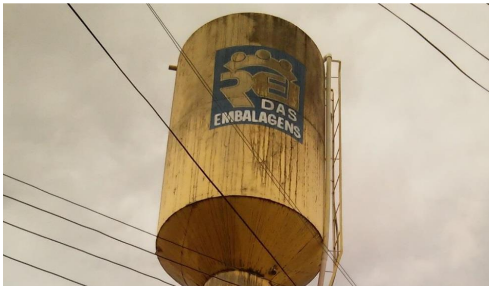
Figura 23 - Material Particulado impregnado em caixa d'água, localizada na Rua Brasília com Sete de Setembro, Porto Velho, Rondônia Autor Robison Costa, março 2015
